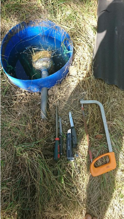
J ai installé un bidon d'environ 100 litres coupé en deux pour faire le bac à graisses, récupéré.
