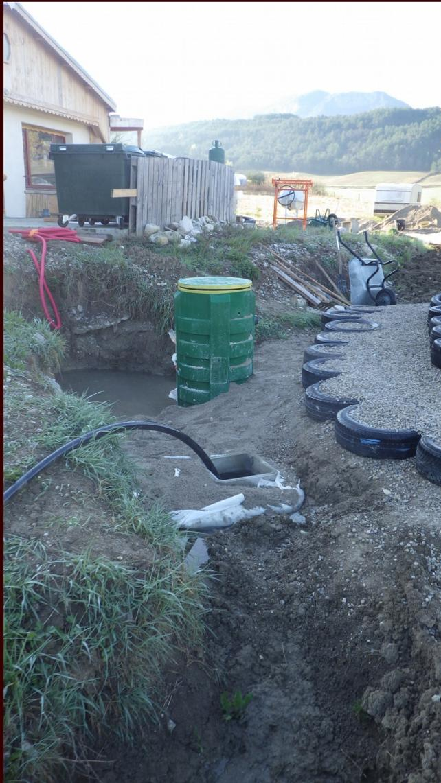
Les spécificités du terrain étaient telles qu'à chaque trou creusé à plus d'un mètre, la nappe d'eau affleurerait. Autre défi, créer de la pente pour l'écoulement des eaux dans le système
